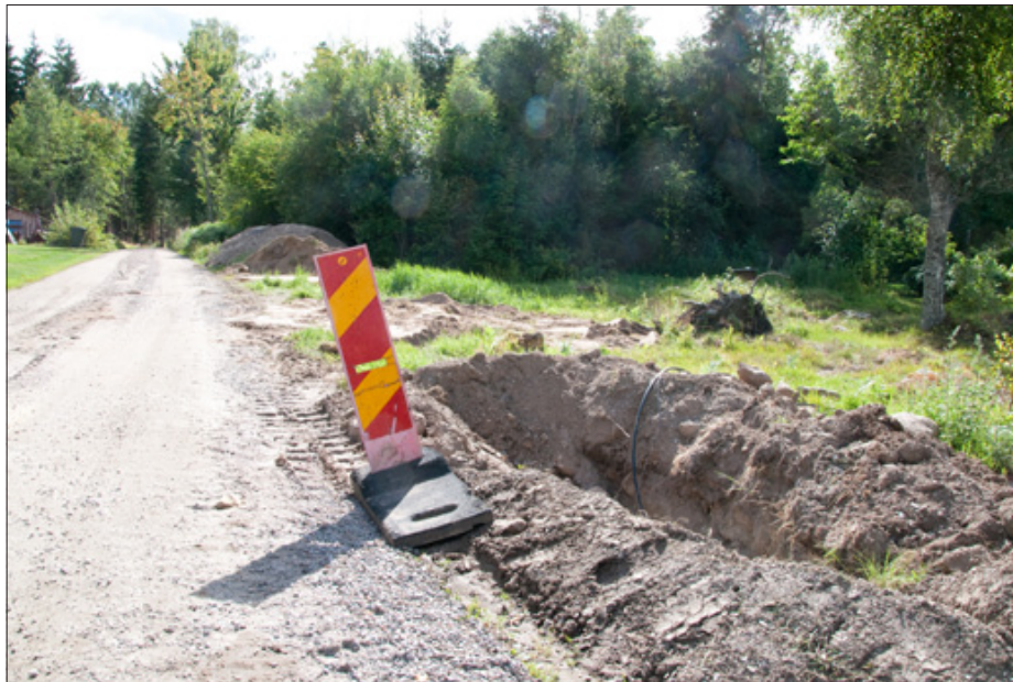
I Brokhult har arbetet med att gräva redan börjat. Med hjälp av pengarna från länsstyrelsen och EU kan det bli färdigt.
